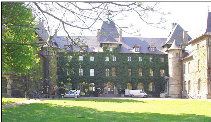
Alnarps Slott, uppfört 1862
